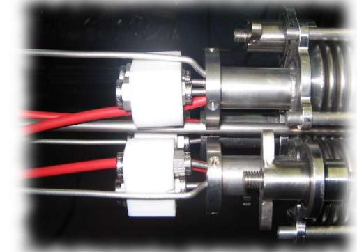
Montaje de caja de conexiones
